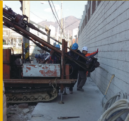
« 영남천연가스 발전소 취수펌프 구조물 차수공사 »
