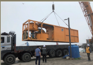
플랜트 전기 및 배관 셋팅 작업
